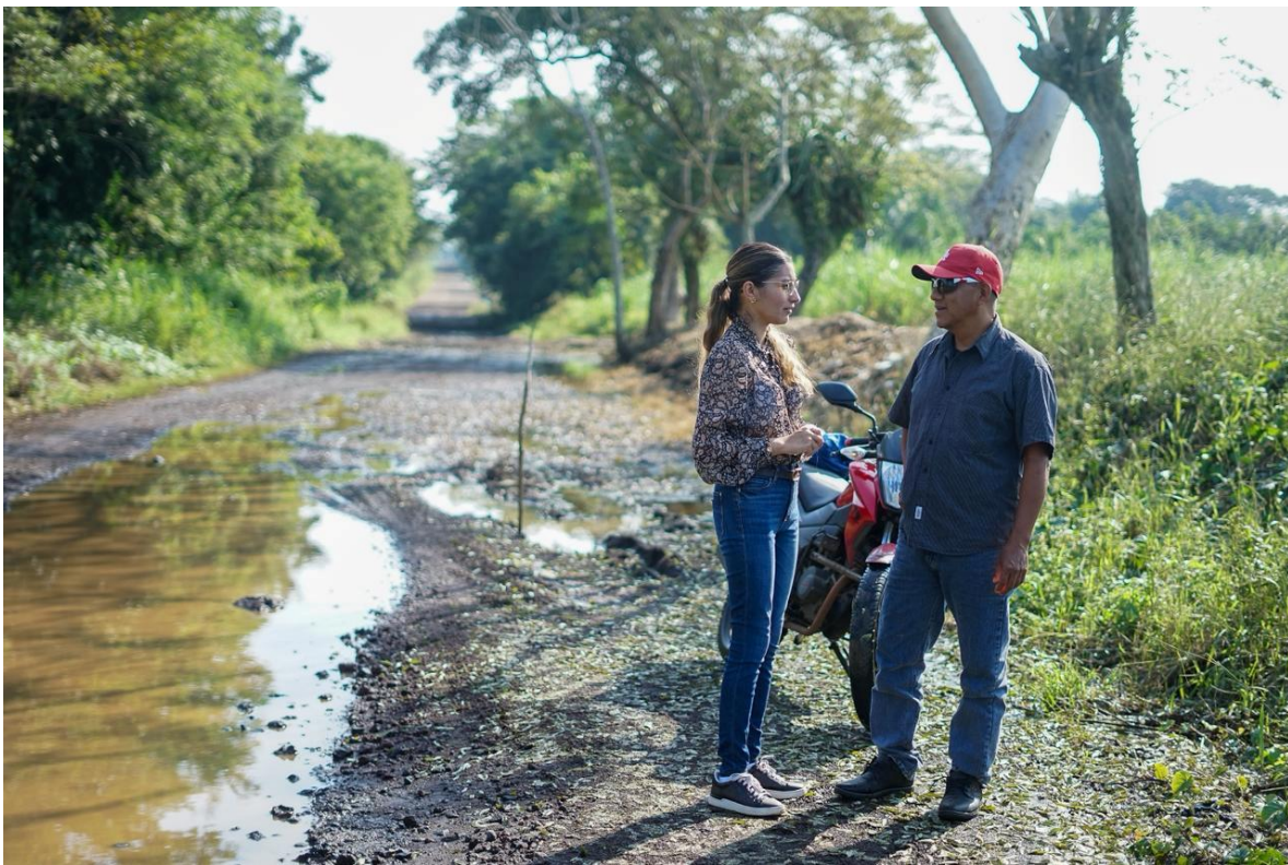
Ilustración 27 Camino en mal estado hacia la comunidad de El Chonegal
