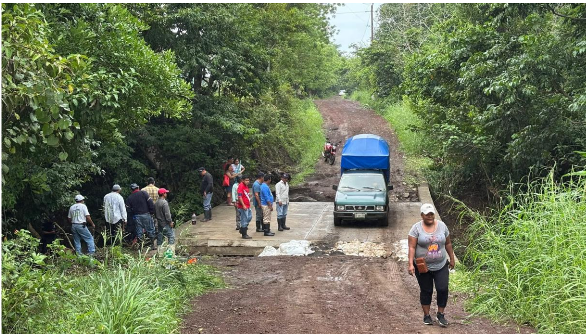
Ilustración 17 Caminos rurales sin pavimento en diversas localidades
